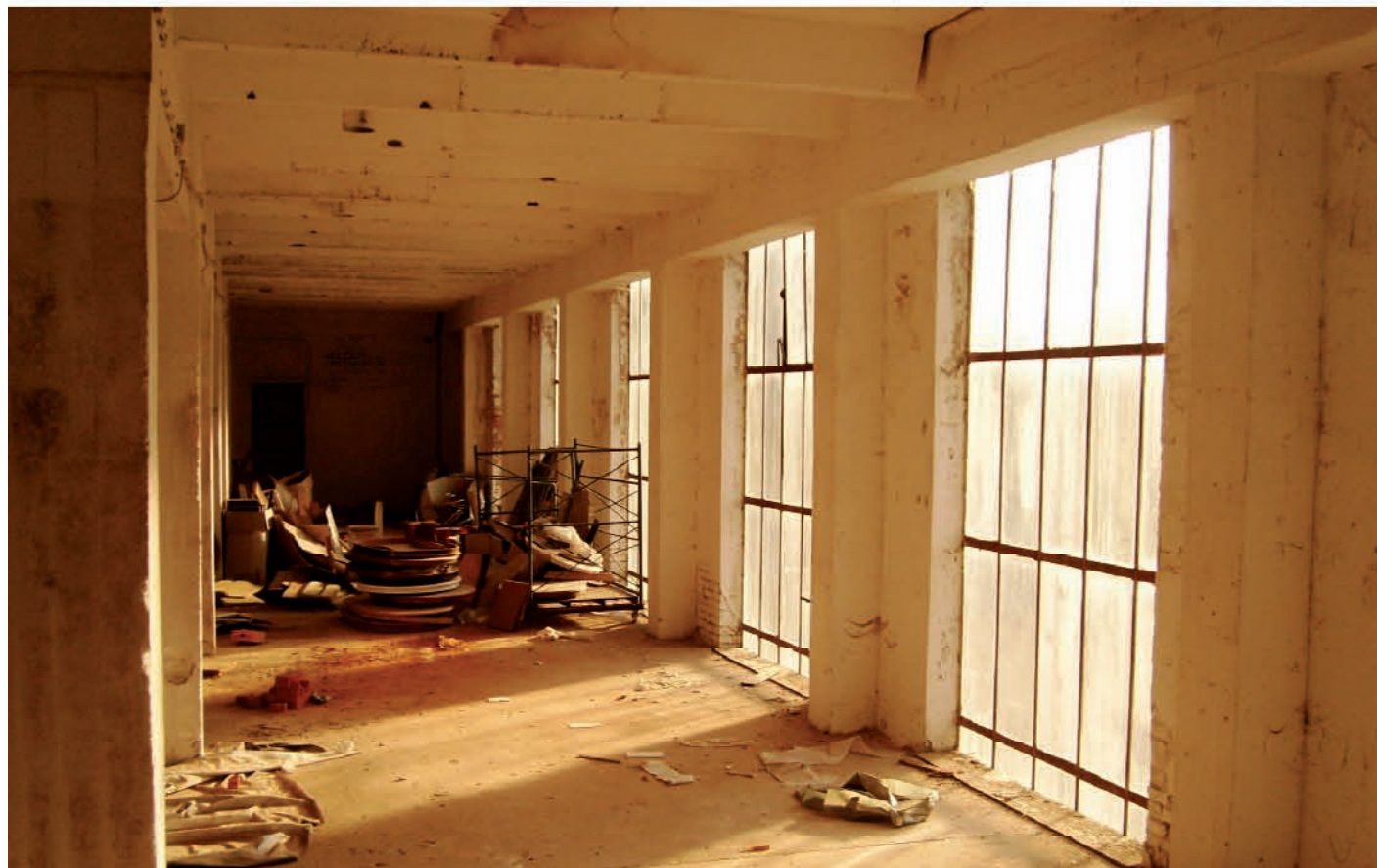
Innenraum Regelgeschoss Hochhaus
